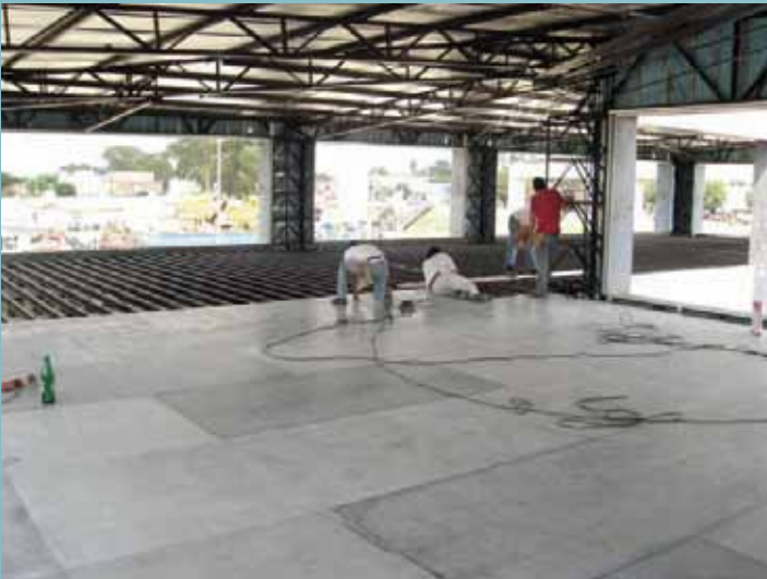
Realizzazione solaio praticabile - Canada
